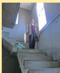
⑧ コンクリートで造った階段。ゆるやかです。
