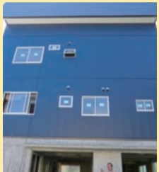
② 外壁は経済的で丈夫で劣化しにくいガルバニウム鋼板をつかいました。
