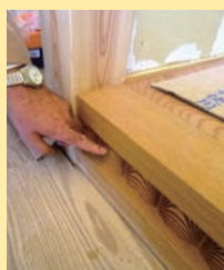
⑫ 和室は塗り壁で柱あらし。仏間の下に彫刻焼き杉を造作しました。
