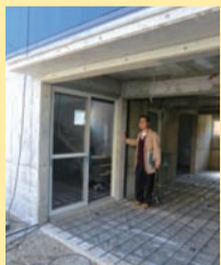
⑦ 入口には戸をつけました。階段が中にあるので冬の雪かたづけも不用です。
