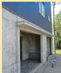
⑥ 1階の入口にはコンクリートで屋根をつけました。雨にあたらず便利です。
